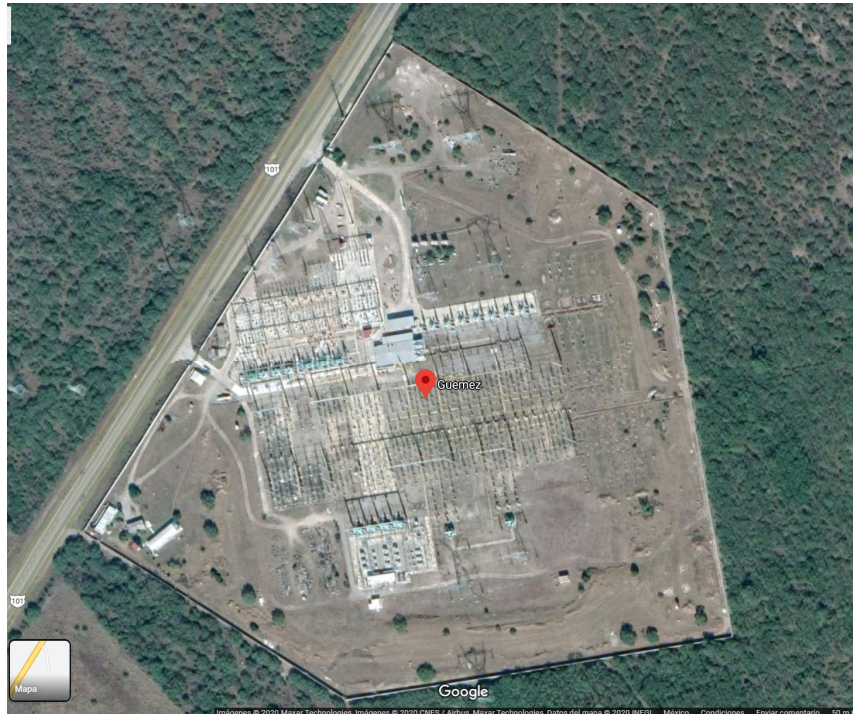
Fuente: Mapa Google - Subestación Güémez.
